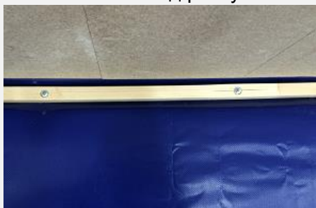
Монтаж под рейку
